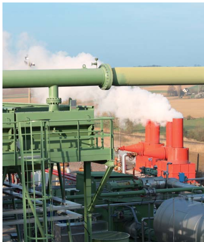
Centrale pilote de Soultz-sous-Forêts
